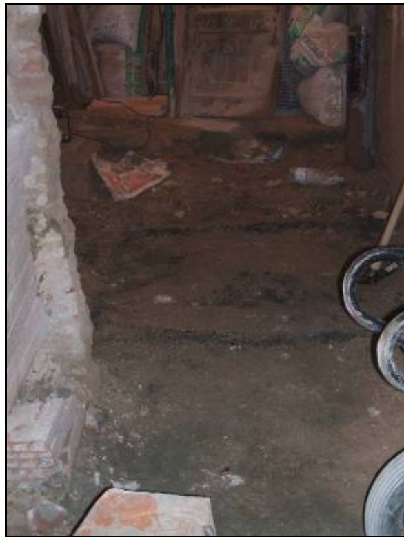
Fotografia 3: Detall de l'espai afectat per l'obra.
